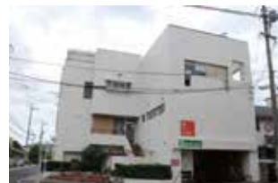
北堀町事業所の外観
